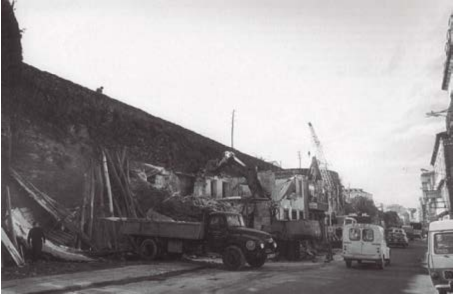
Fig. 4. Demolición de las edificaciones durante la Operación Muralla Limpia
