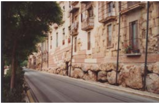
Fig. 32 - . Intervención del Paseo de San Antonio del año 1986.
