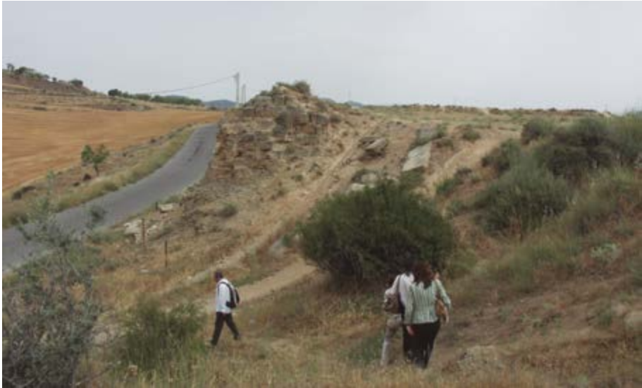
Fig. 4 - Plá d'Almatá (Balaguer, Lérida). Muralla en la zona opuesta al río, donde la topografía obligó a levantar una muralla de tierra, con forros de sillares de arenisca.
