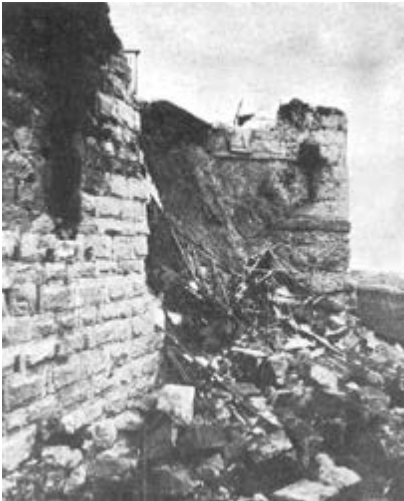
Fig. 25 - Derrumbamiento del tramo de muralla junto a la torre de Minerva, año 1932 (SÁNCHEZ REAL 1986).
