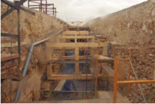
Fig. 40 - Intervención en la Bajada del Rosario, año 2011.
