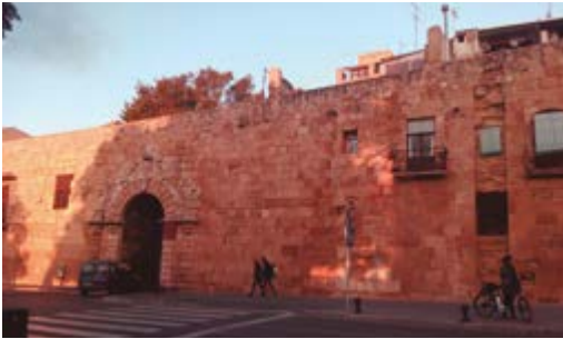
Fig. 35 - Tramo del Paseo de Paseo de San Antonio con reposición de prácticamente toda la sillería dejando una franja de reserva, entre los años 1993 y 1994.
