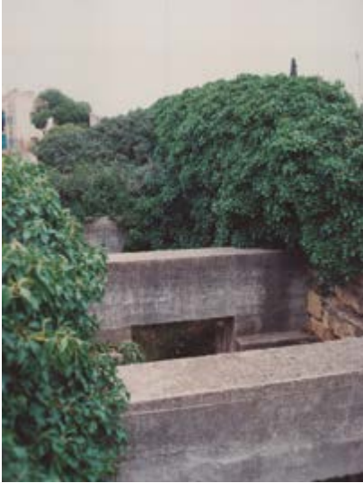
Fig. 26 - Pórticos de hormigón armado construidos por J. Martorell en el tramo de muralla del Matadero.
