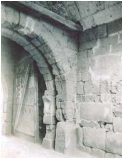
Foto de la puerta de San Vicente de Repulles Vargas antes de la restauración
