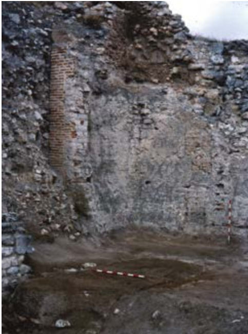
Fig. 6 - Calatrava la Vieja (Ciudad Real). Restos de una torre del primitivo alcázar omeya, en la que se combina la obra de tierra, el adobe y el ladrillo en las esquinas. Fue embutida por otra fortificación posterior, también andalusí, y en gran parte destruida por las obras de restauración del Ministerio de Cultura (1983-1984).
