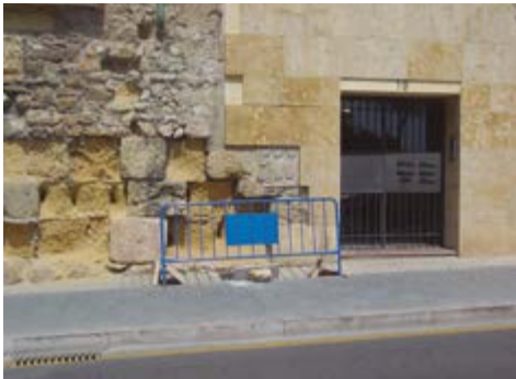
Fig. 47 - Fachada de vivienda de la casa Granada con salida al Paseo de San Antonio. Se ha intentado restituir la sillería de la muralla con placado de piedra, con un resultado como mínimo discutible.
