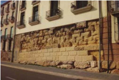
Fig. 36 - Restauración de tramo de muralla del Paseo de San Antonio, correspondiente al número 1 de la calle Granada.
