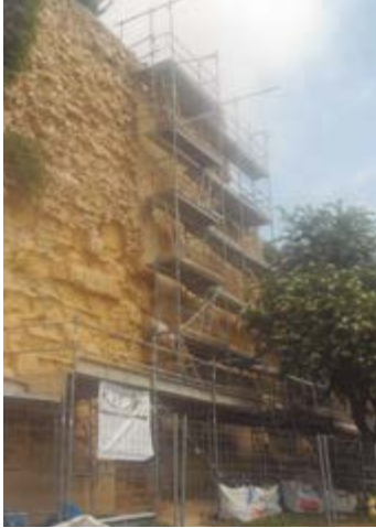
Fig. 45 - Actuación de emergencia junto al baluarte de San Antonio (2014).
