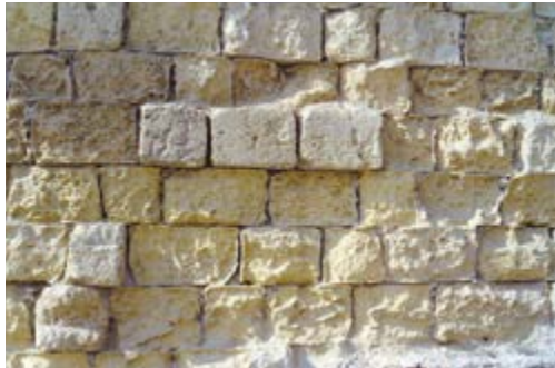
Fig. 51 - Estado de las silleras del tramo del Paseo de San Antonio (s. XVIII) antes de las intervenciones llevadas a cabo.
