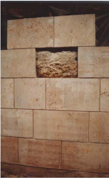
Fig. 33 - Ensayo de sustitución de sillería, con bloques cortados a hilo, prueba realizada en 1990 bajo la supervisión de A. Bruno.
