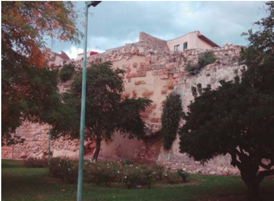
Fig. 54 - Acabado de la intervención de emergencia de 2014 junto al baluarte de San Antonio. Aquí la actuación fue simplemente macizar los espacios vacíos con mortero, gero y revoco pigmentado.
