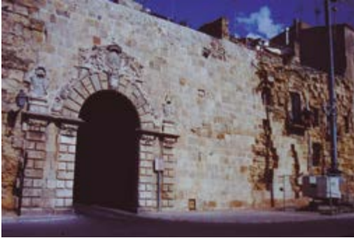
Fig. 34 - Trabajos en el Paseo de San Antonio con reposición de sillería dejando ventanas o espacios sin intervenir para diferenciar así las partes. Año 1991.
