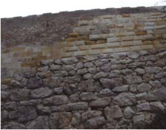
Fig. 44 - Sustitución de sillería en el tramo del colegio Lestonnac
