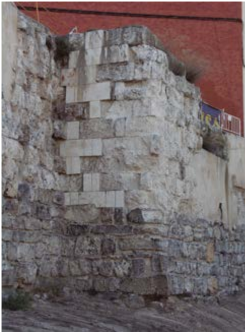
Fig. 5 - Madrid. Cuesta de la Vega. Torre de flanqueo de la muralla omeya. De sillares de pedernal en la parte baja y de caliza, a sogá y tizón, en la parte superior.
