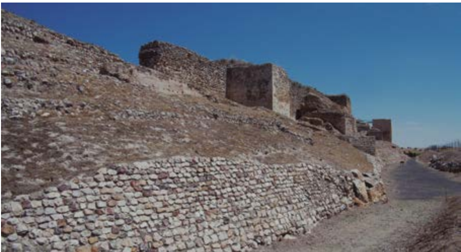
Fig. 9 - Calatrava la Vieja (Ciudad Real). Muralla sur y foso seco, que rodeada por completo la ciudad en la parte no defendida por el río Guadiana. Se muestra su escarpa con forro de mampuestos.
