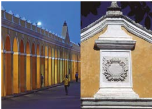
Cuartel de las Bóvedas
